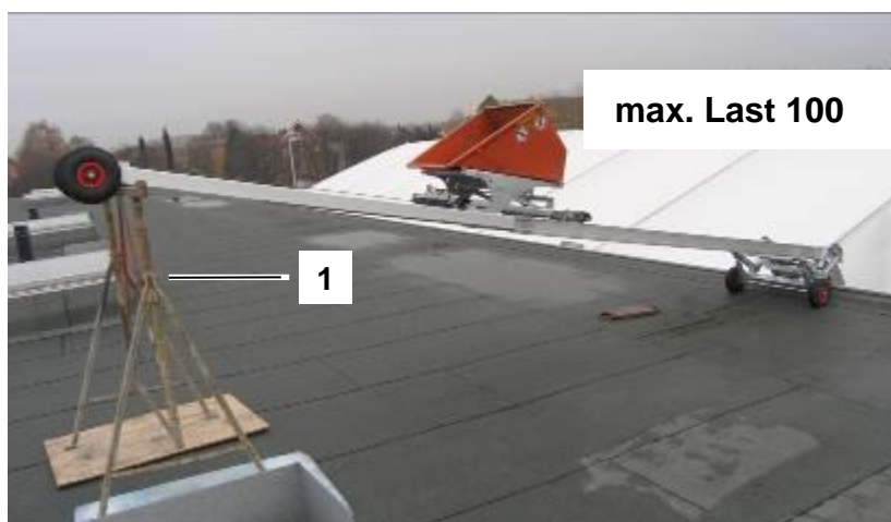
Afb. 86: Belasting en steuninrichting bij 100kg last
