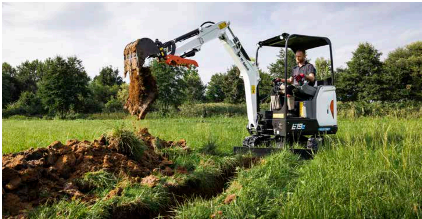
Trenching with the E19e
